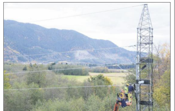
SLUTTSTYKKET: Montører er i gang med å klargjøre blant annet denne endemasta ved Melhusbrua, for påsetting av spenning. Fra endemasta er det jordkabel bort til trafostasjonen ved Melhus videregående skole.
